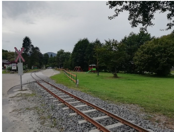
A kisvasút a belterület északi részén
